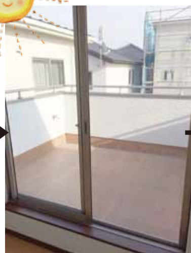
南面ベランダテラス
