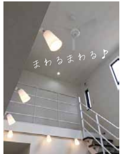
スポット照明6カ所とシーリングファン
